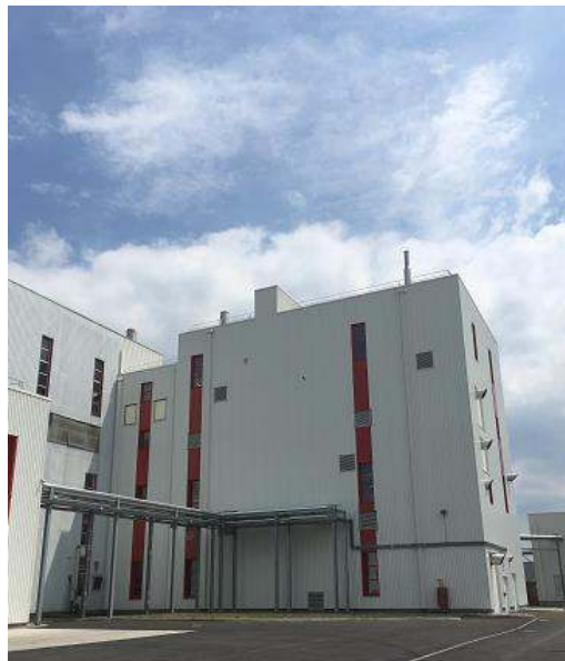
Nouvelle tour de séchage Biospringer Strasbourg
